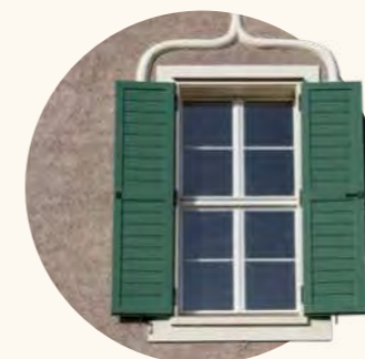
Fenster mit Fensterladen, Rekonstruktion des Zustandes aus der Mitte des 19. Jahrhunderts
