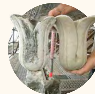
Tulpenartiger Aufsatz auf den Fialen, Original und Rekonstruktion
